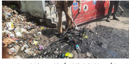
ఇబ్బందులు పడకుండా తక్షణమే సహాయక చర్యలు చేపట్టాలని అధికారులను ఆదేశించారు. ఎమ్మెల్యే ఆదేశాల మేరకు జీహెచ్ఎస్ఐ సిబ్బంది రంగంలోకి దిగి మ్యాచ్ బోల్స్ కు అడ్డుగా ఉన్న చెత్తను తొలగించి నిలిచిపోయిన నీటిని బయటకు పంపించారు. అలాగే రోడ్లపై పేరుకుపోయిన మట్టి, ఇతర వ్యర్థాలను తొలగించే పనులను కూడా చేపట్టారు. నైరతి
